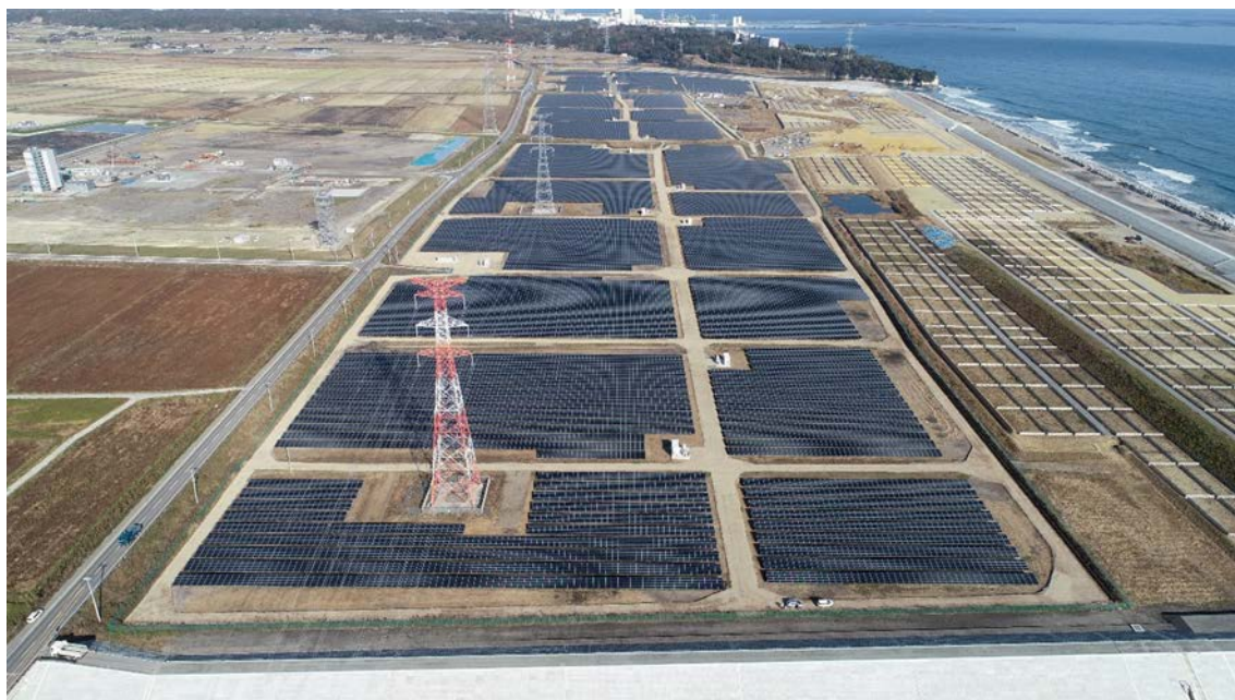
【竣工した南相馬原町東太陽光発電所】
