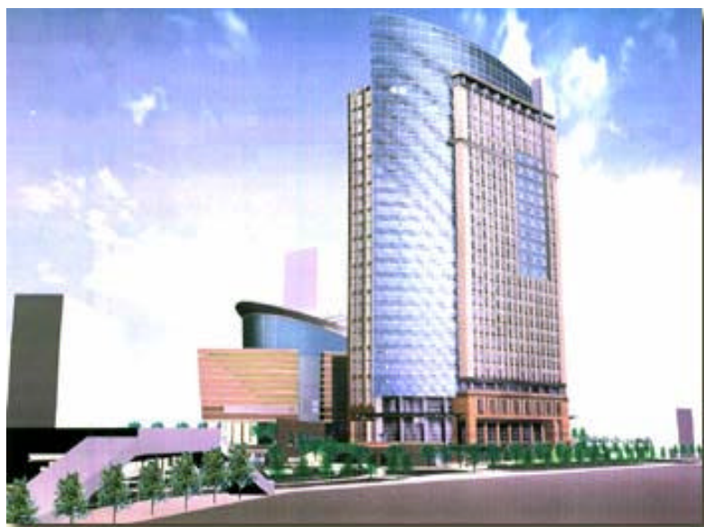
右側オフィス棟が本件ファイナンスの対象であるミュージザ川崎セントラルタワー
