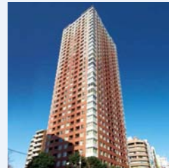
住宅 ウエストパークタワー池袋 オリックス不動産投資法人 所在地: 東京都豊島区
