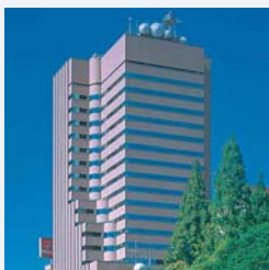
オフィス NHK広島放送センタービル ジャパンリアルエステイト投資法人 所在地: 広島県広島市
