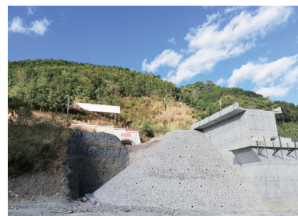
建設中のラオス中国高速鉄道(みずほ銀行撮影)
