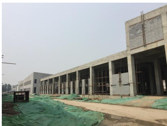
河北省にある建設中の工業園區
