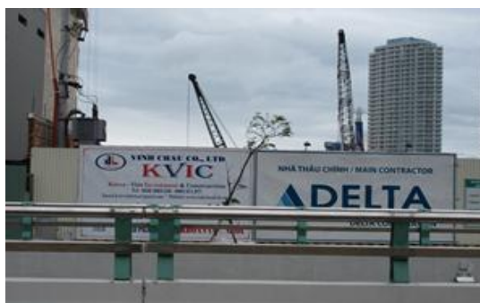
外国投資家と現地企業のJVによる建設現場
