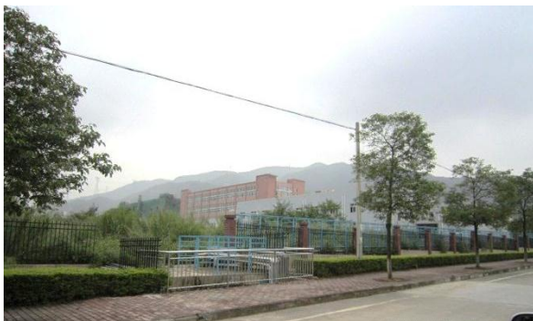
大規模な污水处理場(写真手前)を有する清遠市龍湾電鍍定点基地
